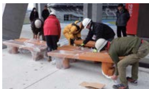
据え付け状況
