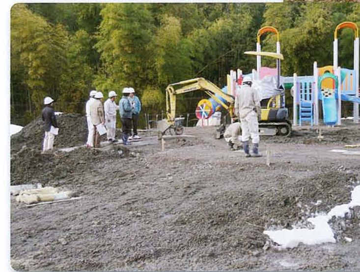
鳥居本公園遊戯施設整備工事
