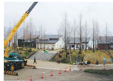
25tラフターで景石吊上げ作業
